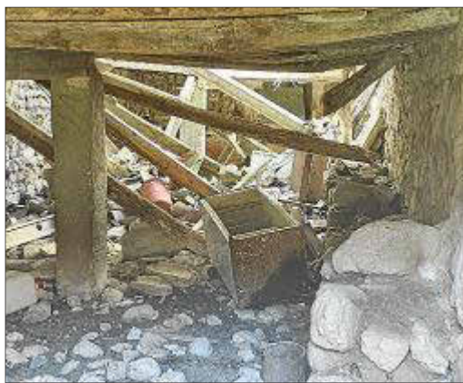
Imatge de com està l'interior d'un edifici.
