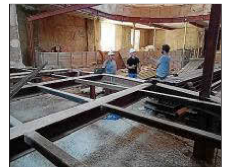
Jaume Bestard va visitar les obres.
